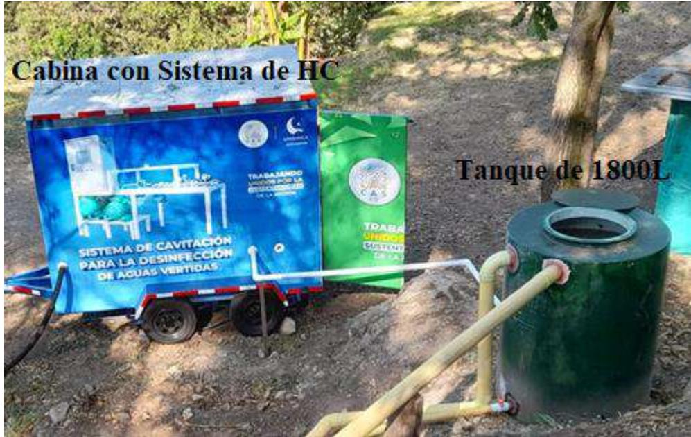
**Figura 41.** Foto cabina con sistema HC para procesamiento in situ de aguas residuales vertidas al río Fonce. Fuente: Los Autores.
